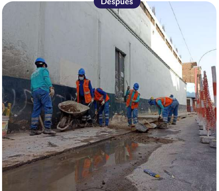
Levantamiento de vereda para evitar la invasión de vehículos
