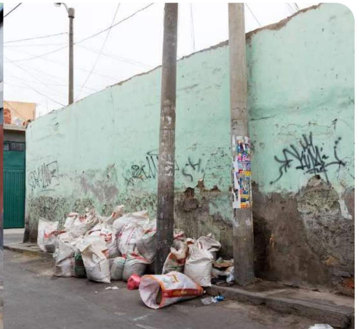
Recuperación de puntos críticos - Pj. Oropesa
